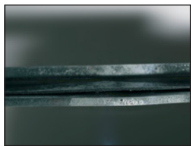
Junta de dilatación en su estado original
